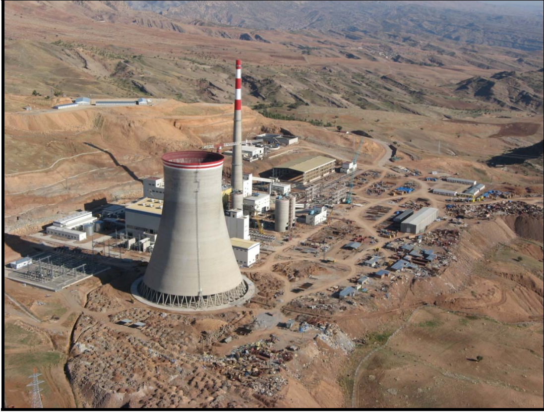
Şekil 2. Silopi Termik Santrali I. Üniteye Ait Fotoğraf
